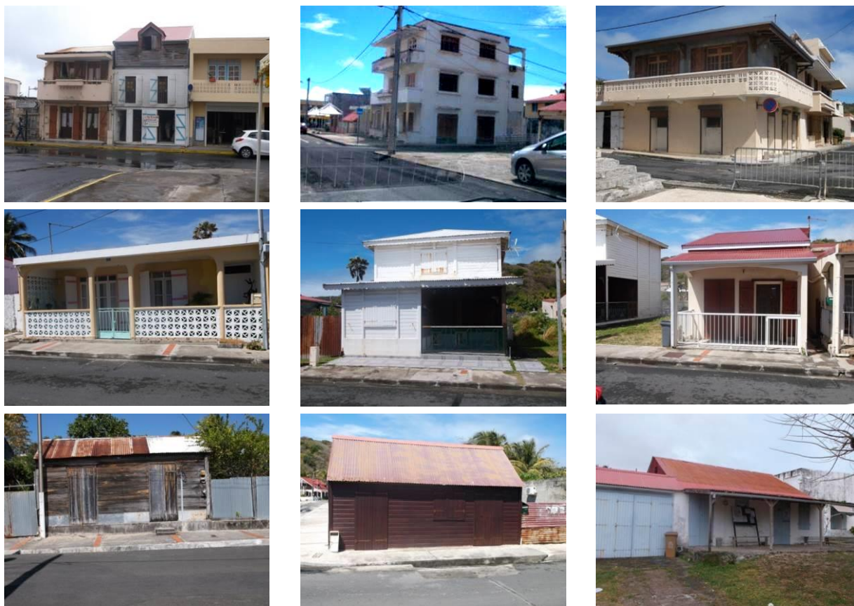
Figure 23: Illustrations de bâtis traditionnels du centre-bourg de Capesterre (Source : DAUE Prospectives, 2014)
